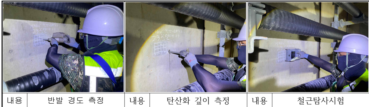
【사진 9.4】 문산SS인출 전력구 재료시험 전경
